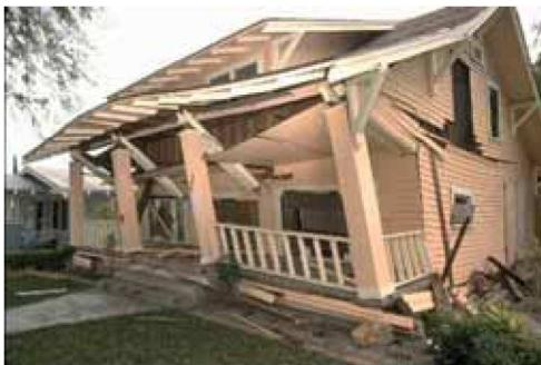
**Slika 1.** Northridge, ZDA, 1994; delna porušitev lesene konstrukcije zaradi nepravilne zasnove -vpliv torzije objekta in prevelike podajnost sprednjega dela konstrukcije.
