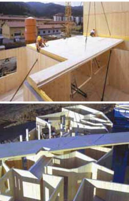
**Slika 5.** Uporaba križno lepljenih leseni masivnih plošč za medetažno konstrukcijo bistveno izboljša sodelovanje vseh stenskih elementov v spodnji etaži pri vodoravnem odzivu konstrukcije na potresno obtežbo.
